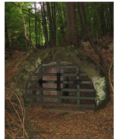
Egestorfer Stollen am Stockbach
